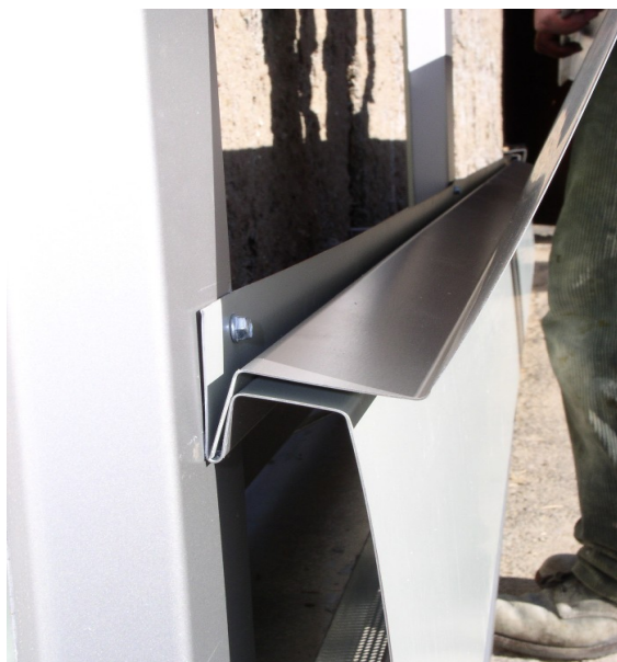
Obr. 18 Schéma zámku lamel.
