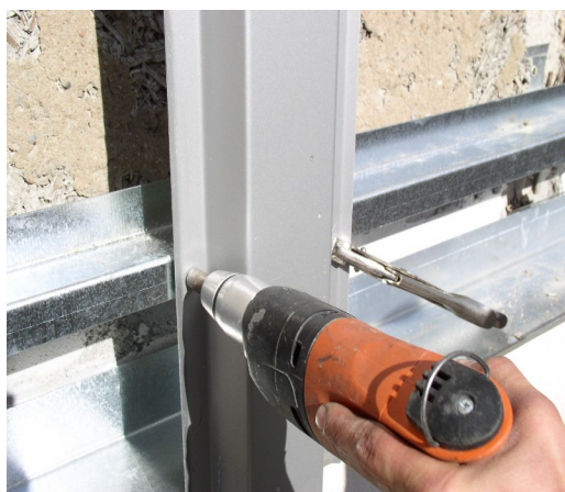
Obr. 13 a obr. 14 Montáž profilů OM
