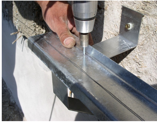
Obr. 8 Osazení profilu Z50 na A-konzolu.
