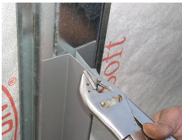
Obr. 47 Úprava vrcholu T lišty.
