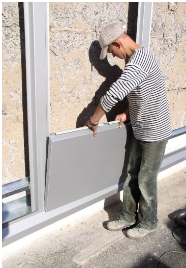
Obr. 17 Osazení první kazety
