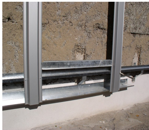
Obr. 13 a obr. 14 Montáž profilů OM
